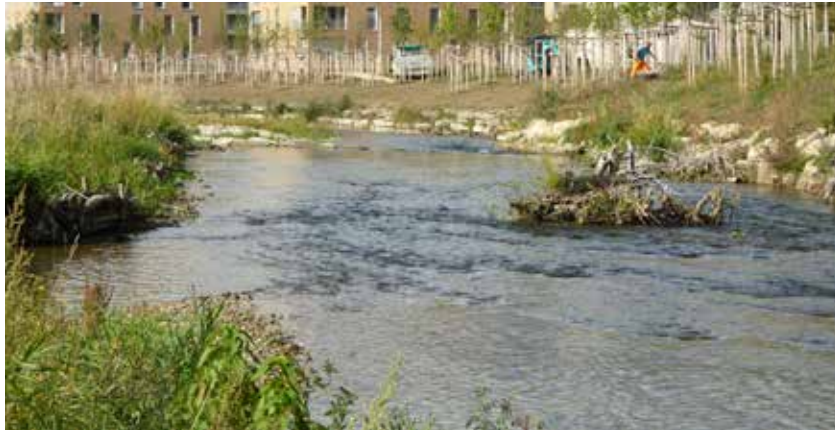
Typische Gerinneform der Schüss entlang des Schüssinselparks. Die steile Böschung der Aussenkurve (rechte Seite) ist mit einem Holzkasten aufgebaut. Auf der linken Gleithangseite findet sich eine strukturierte Flachwasserzone.
