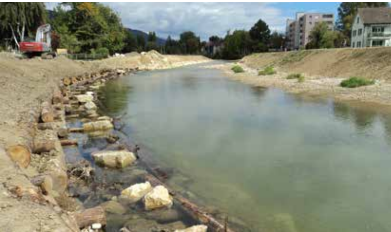
Holzkastenwand mit ausgezeichneten Unterständen am Prallufer während der Bauphase.
